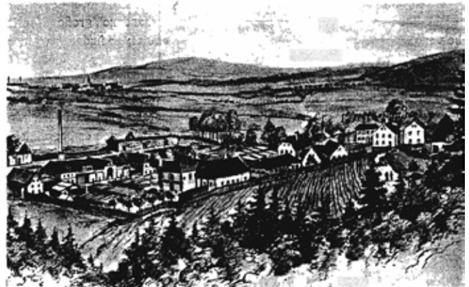
Fabrikneubau nach dem Brand
